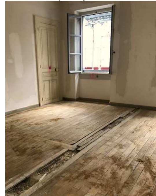
Restauration des parquets
