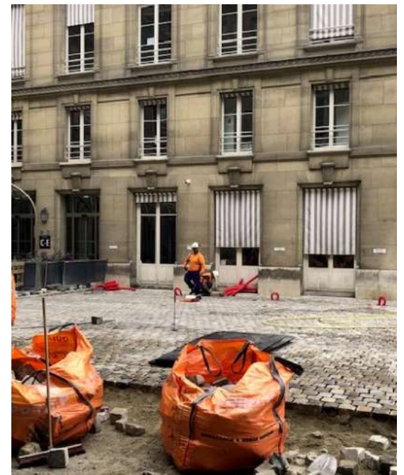
Réfection de la cour n° 2
