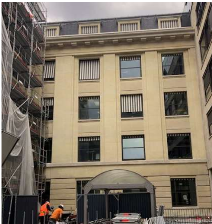
Façade bât D - cour n°4
